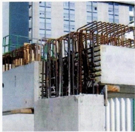
Fig. 7 Nœud poteaux poutre
