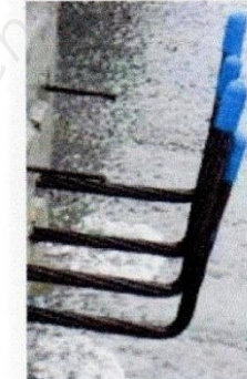
Fig. 13 Aciers poutre BA préfabriquée - KP1
